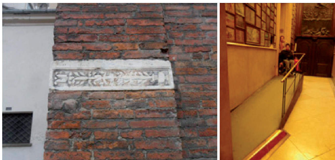
- Bell Tower, detail - Santuario della Consolata: inside ramp
